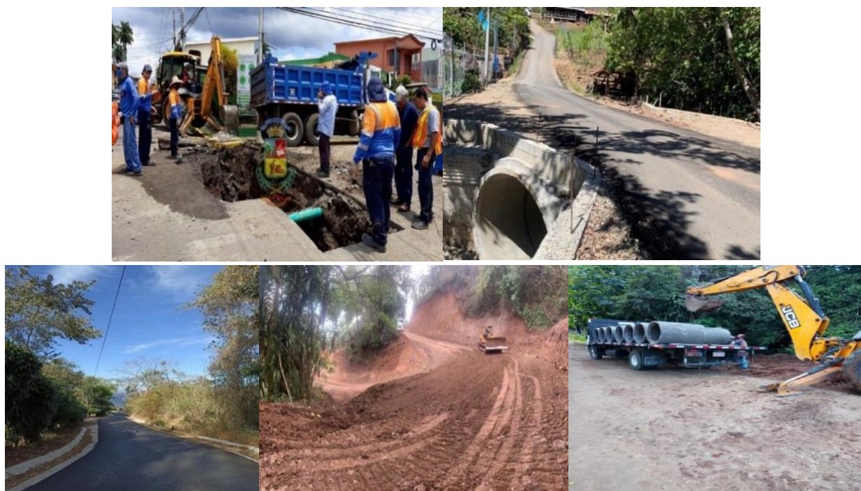
Imágenes: Mantenimiento y construcción de Carreteras y caminos cantonales.
